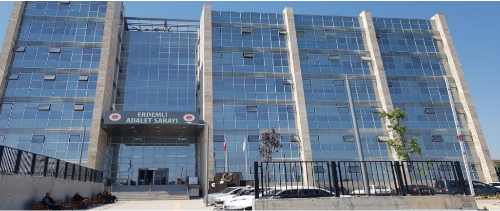
MERSİN ERDEMLİ ADALET SARAYI ANA YÜKLENİCİ: ORC İNŞAAT
