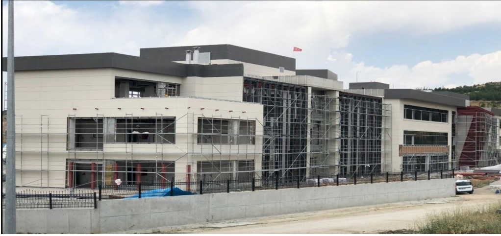
YOZGAT AğıZ VE DİŞ SAęLIęI MERKEZİ ANA YÜKLENİCİ: ONDOKUZ MÜH. İNŞAAT
