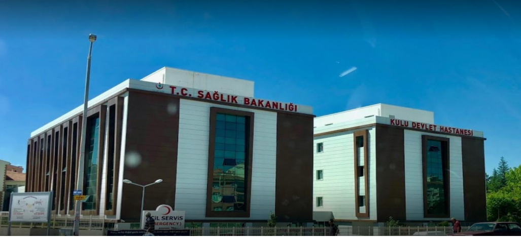
KONYA KULU 75 YATAKLI DEVLET HASTANESİ ANA YÜKLENİCİ: ONDOKUZ MÜH. İNŞAAT
