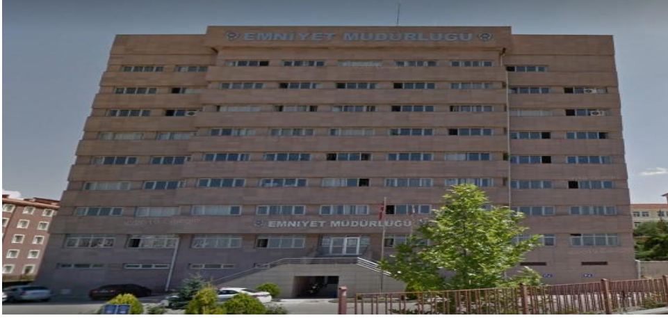
YOZGAT EMNİYET MÜDÜRLÜĞÜ ANA YÜKLENİCİ: KILIÇASLAN İNŞAAT
